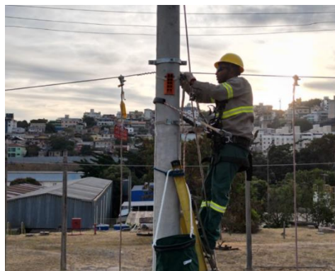
Foto demonstrando o executante realizando os ajustes no degrau de fibra.
