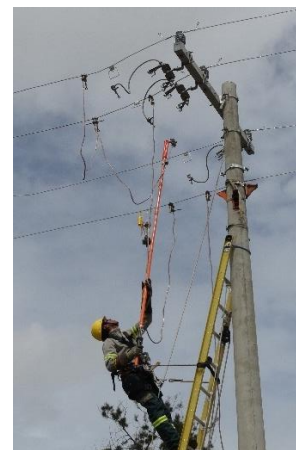
Foto demonstrando a conexão do último grampo de aterramento
