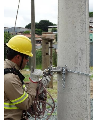
Foto conectando o grampo de aterramento na sela já instalada
