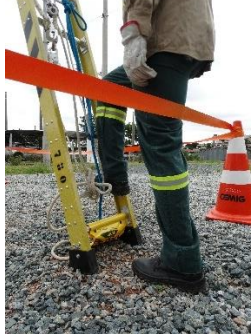
Foto demonstrando o último/primeiro degrau permitido para descida/escalada do eletricista.
