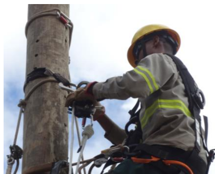
Fotos demonstrando o executante posicionado para realizar o resgate de eletricista acidentado.
