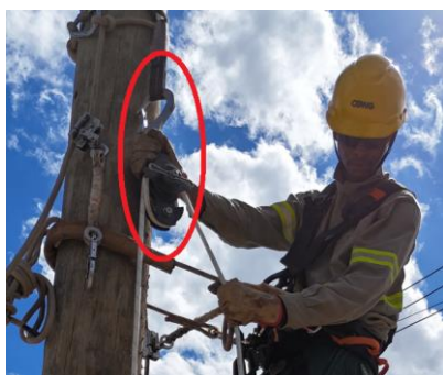
Foto demonstrando a descida do acidentado utilizando o freio da carretilha dupla ação.
