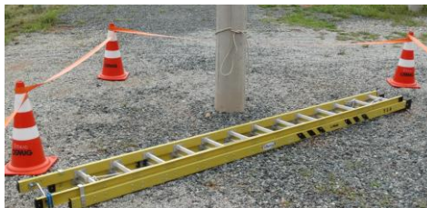
Foto demonstrando a linha de vida amarrada na base do poste
