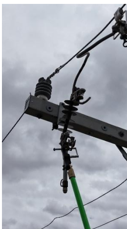
Foto demonstrando a instalação da porta fusível utilizando o dispositivo antiqueda de cartuchos DAQC.
