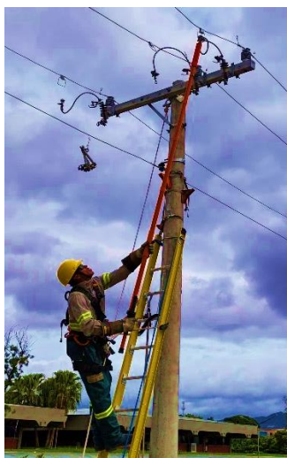
Foto demonstrando a instalação do grampo de linha viva.
