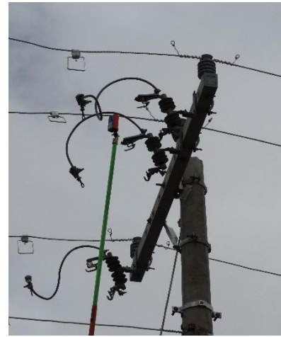
Foto realizando o teste de ausência de tensão na rede
