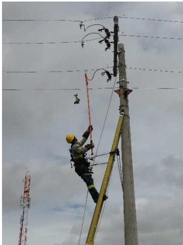
Foto demonstrando a retirada do grampo de linha viva da chave
