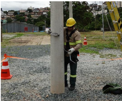
Foto demonstrando a instalação da sela de aterramento
