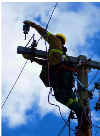
Foto demonstrando a retirada do isolador de pino.
