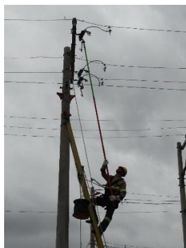
Foto demonstrando executante retirando o porta fusível
