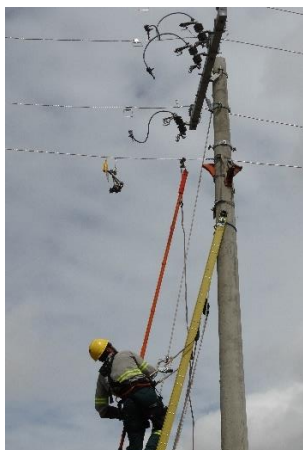
Foto demonstrando a conexão do grampo da sela ao neutro
