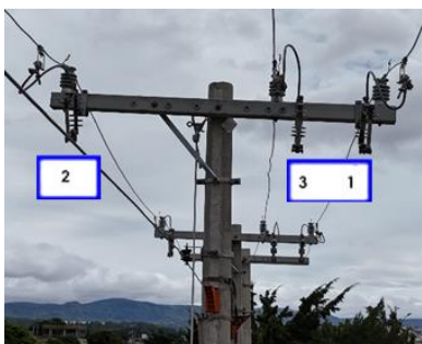
Foto demonstrando a sequência de abertura das chaves
