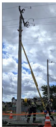
Foto demonstrando a realização da laçada no topo da escada
