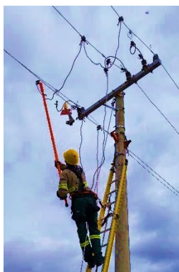
Foto demonstrando o início da retirada do aterramento temporário
