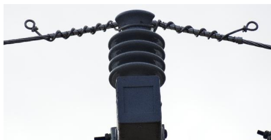
Figura e foto demonstrando a amarração de topo do isolador
