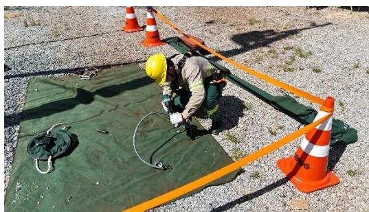
Foto demonstrando o auxiliar conferindo o aperto da conexão do jumper.
