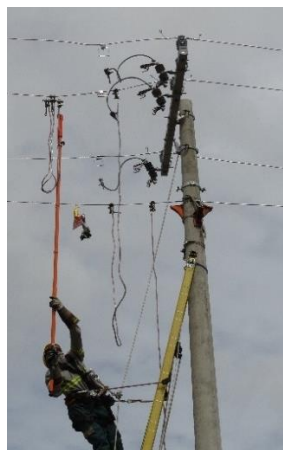
Foto demonstrando a conexão do grampo as fases
