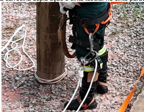
Foto demonstrando a carretilha dupla ação pendurada no cinto paraquedista
