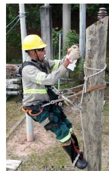
Foto demonstrando a substituição do balde no topo do poste.
