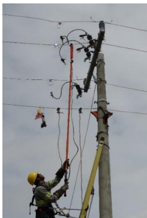
Foto demonstrando a conexão do grampo neutro a fase
