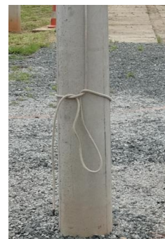
Foto demonstrando a linha de vida amarrada na base do poste
