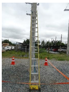
Foto demonstrando a escada recolhida na estrutura
