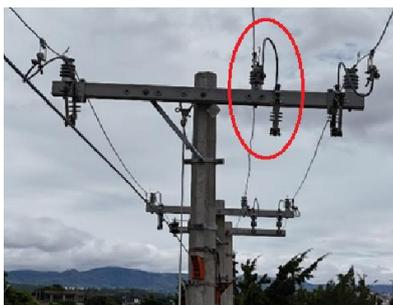
Foto demonstrando a chave a ser substituída.
