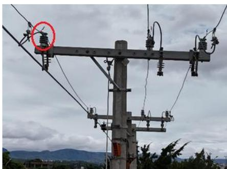
Foto demonstrando o isolador a ser substituído.
