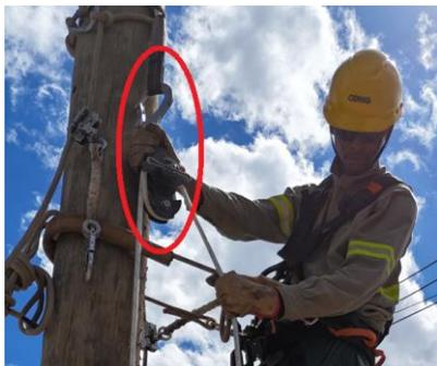
Foto demonstrando a descida do acidentado utilizando o freio da carretilha dupla ação.
