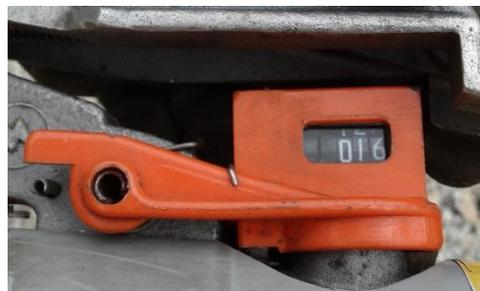
Foto exemplificando um DAC que possui contador de operações.
