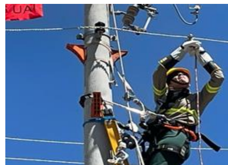
Retirando o grampo do neutro com luva isolante.
