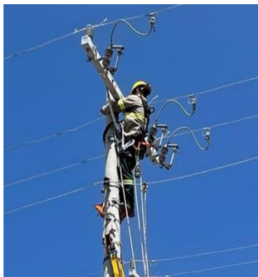
Fotos demonstrando o executante posicionando no degrau de fibra para realização da atividade.
