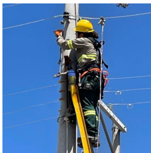
Foto demonstrando o executante realizando o ajuste dos degraus de fibra.
