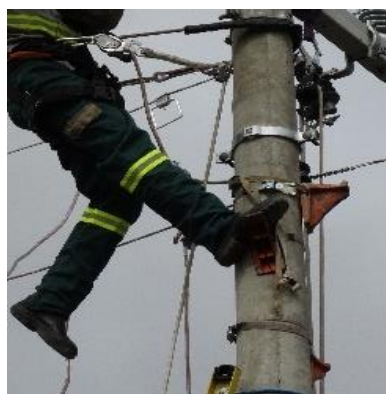
Foto demonstrando o executante posicionado com um pé no degrau
