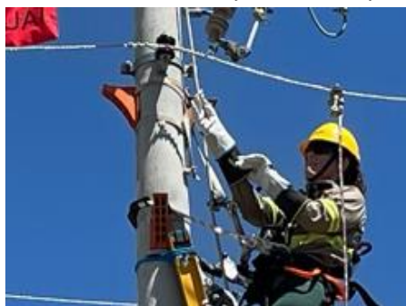
Substituindo a luva de vaqueta pela luva isolante.
