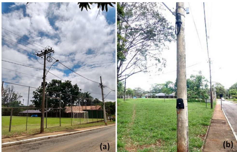
Figura 7 - (a) Foto de parte da Rede Sinérgica e (b) foto de uma CTO e CEO fixadas em um dos postes da Rede Sinérgica.
